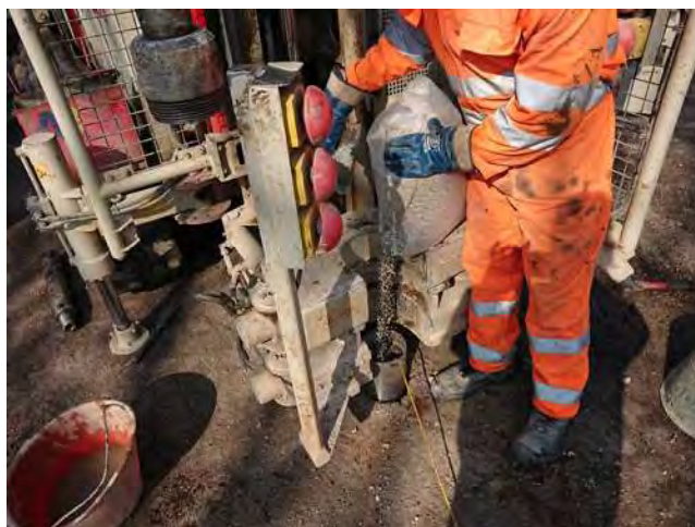
Preparazione tasca con inserimento ghiaietto siliceo 4-6 mm
