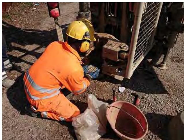
Preparazione tasca con inserimento ghiaietto siliceo 4-6 mm
